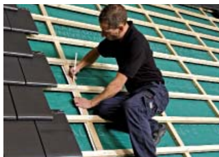
1. Măsurarea modulului și pregătirea acoperișului
