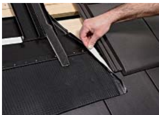
14. Instalarea șorțului de etanșare*
