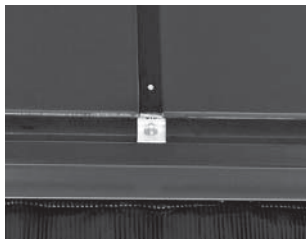
Gata fixată cu șuruburi
