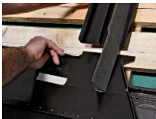
12. Instalarea șorțului de etanșare
