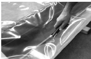
Tăierea foliei și despachetarea colectorului
