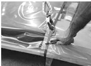
Demontajul ambalajului de pe panoul solar
