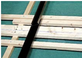
6. Instalarea jgheabului de drenaj
