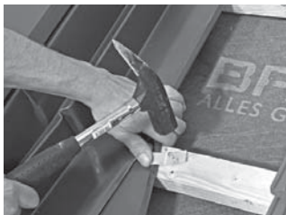
Rama de etanșare din tablă se fixează cu clemele de tablă, astfel încât să stea pe șipșii suport cât mai bine
