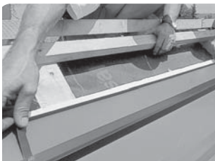
Montajul profilului din aluminiu
