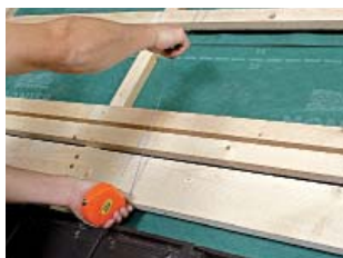
3. Trasarea în vederea montării jgheabului de drenaj
