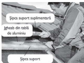
În caz de necesitate montați șipca suplimentară
