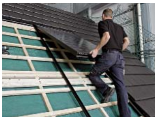
9. Instalarea modulelor se face de sus în jos
