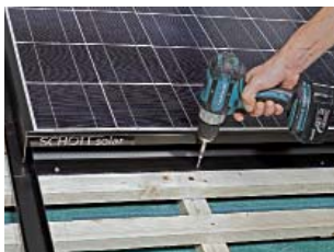
16. Instalarea ultimului rând de module cu ajutorul șuruburilor livrate de Bramac
