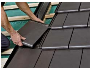
8. Montarea țiglelor laterale. Tăiați țiglele conform manualului de instalare, dacă este necesar. Buretele trebuie plat înșpre rama de etanșare (NU înșpre acoperiș)!
