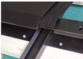
7. Instalarea ramei de etanșare superioară
