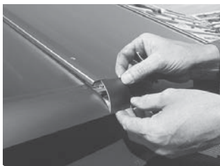
Poziționați cu precizie profilul clips din aluminiu și apăsați în direcția șipșii din aluminiu
