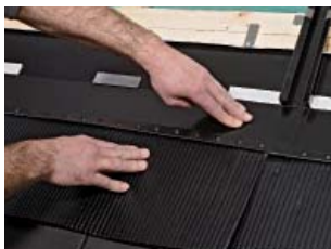
13. Instalarea șorțului de etanșare
