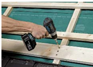
2. Instalarea scândurii de susținere cu ajutorul șuruburilor livrate de Bramac (verificate static)
